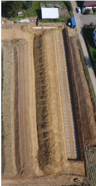
Verlegung Erdkollektoren
