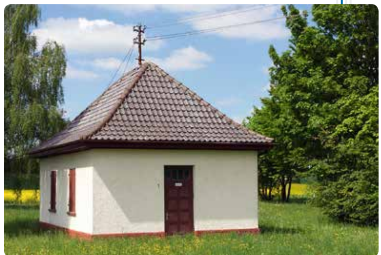
Idyllisch gelegen: das Pumpwerk Hailfingen
