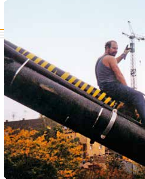
Stadtwerke-Artisten bei der Arbeit: Die neuen Gasrohre werden verlegt
