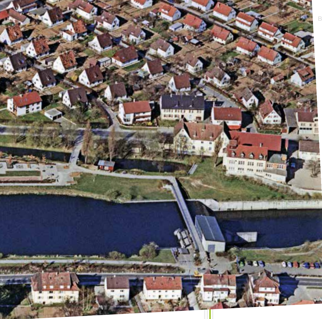
Ein großer Rottenburger Energielieferant von oben
