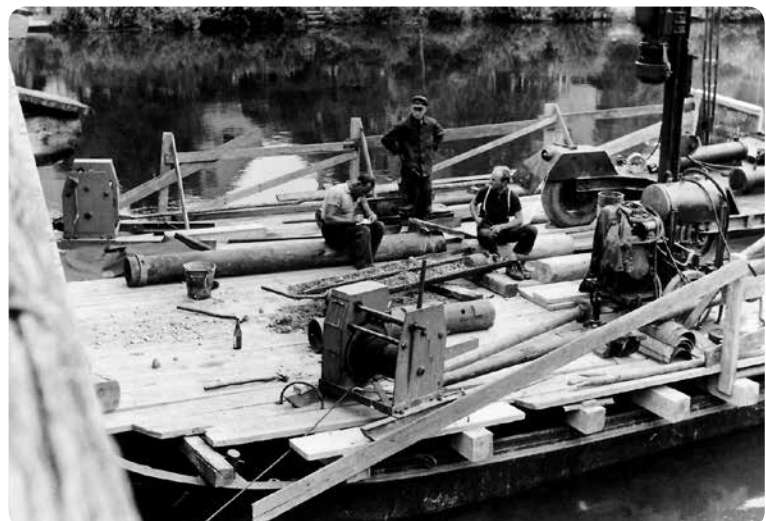
Für das neue Kraftwerk muss das Flussbett des Neckars ausgegraben werden
