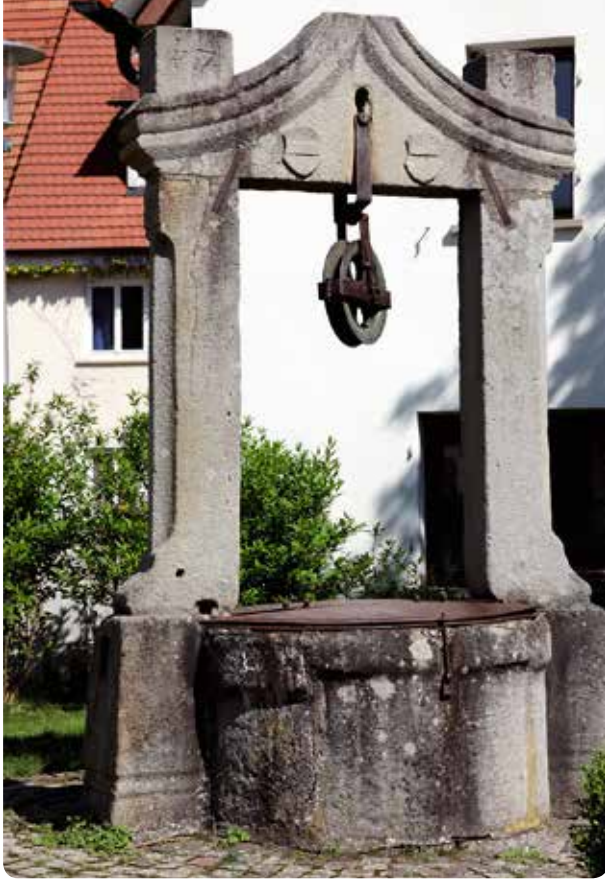
Der Rädlesbrunnen Kiebingen ist ein besonderes Zeugnis für die Geschichte der Wasserversorgung
