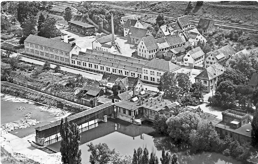
Das alte Fallenwehr ist noch in Betrieb. Im Hintergrund sieht man das Gelände der Uhrenfabrik Junghans
